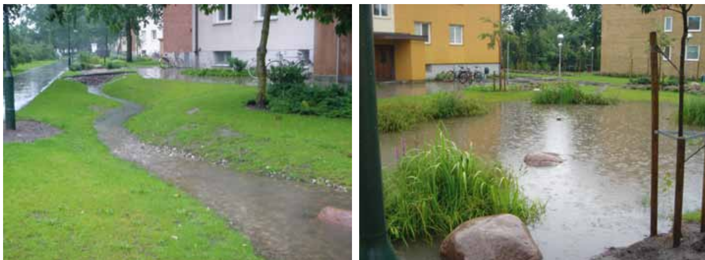
Figur 2. Exempel från stadsdelen Augustenborg i Malmö, där trög avledning i allmän platsmark arrangerats genom att utnyttja terrängens och markens magasiningsförmåga på ett kontrollerat sätt.
