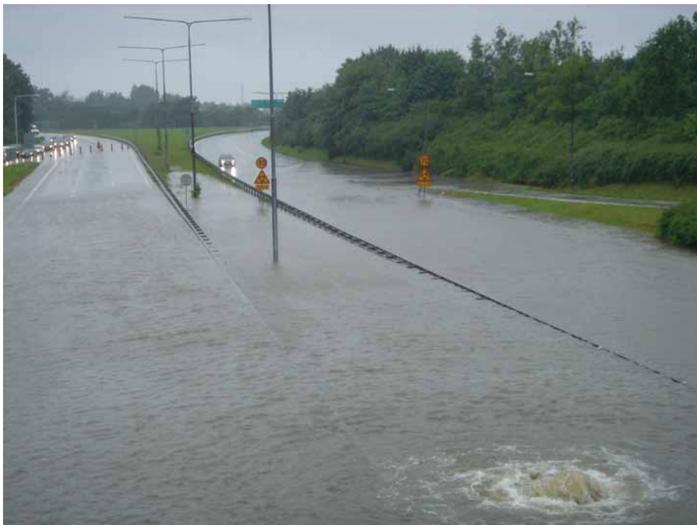
Figur 1. Översvämmad trafikplats på Inre ringvägen i Fosie, Malmö, till följd av överfullt dagvattensystem med dagvatten som sprutar upp ur brunnen och ytvatten som inte kan rinna ned i ledningssystemet. Här finns ett hårt strypt dagvattensmagasin som överbelastas vid kraftiga regn.
